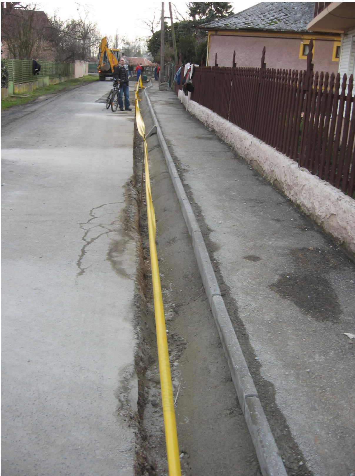
9. mélyépítési munkák előrehaladása
