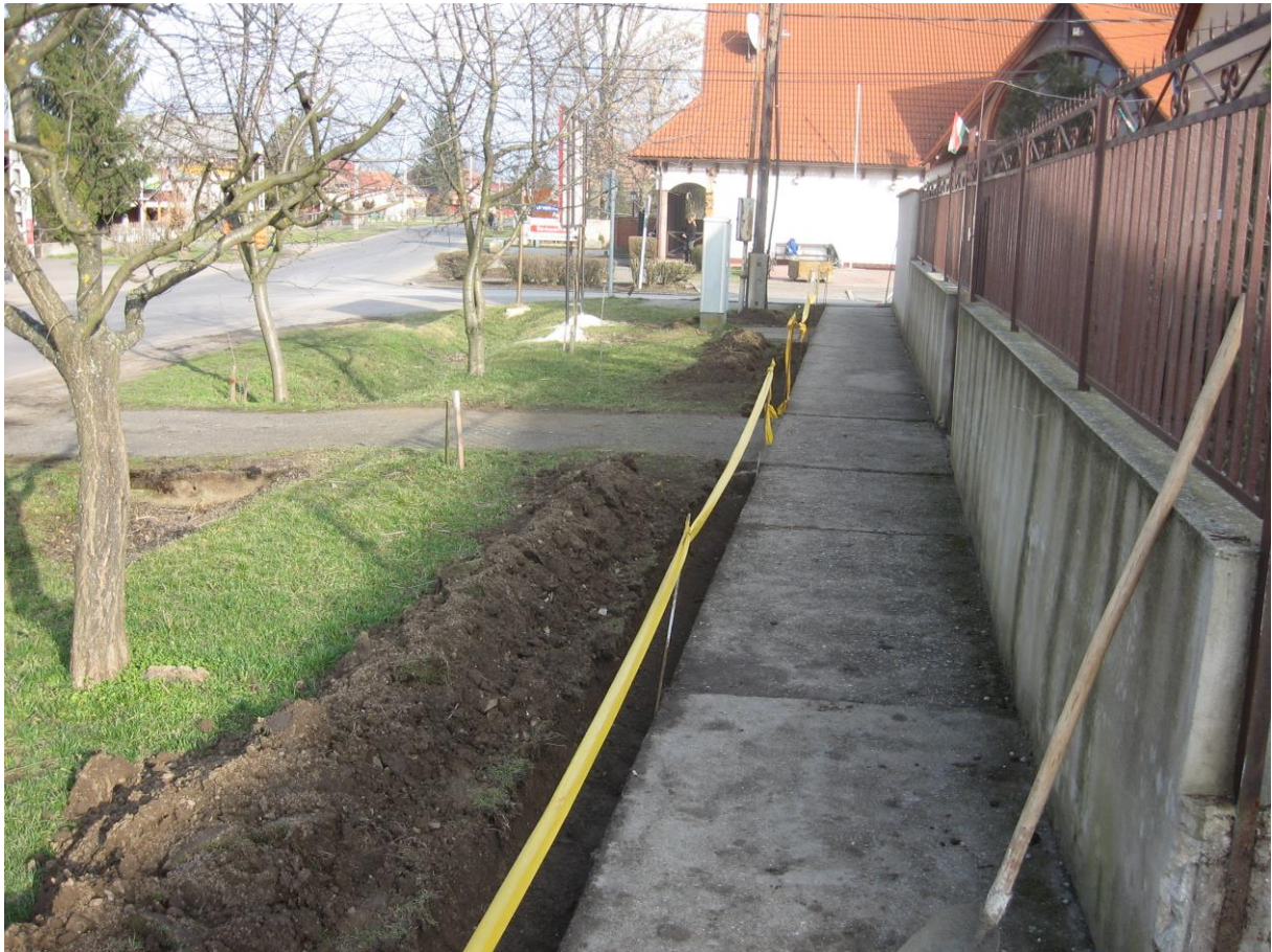
10. mélyépítési munkák előrehaladása
