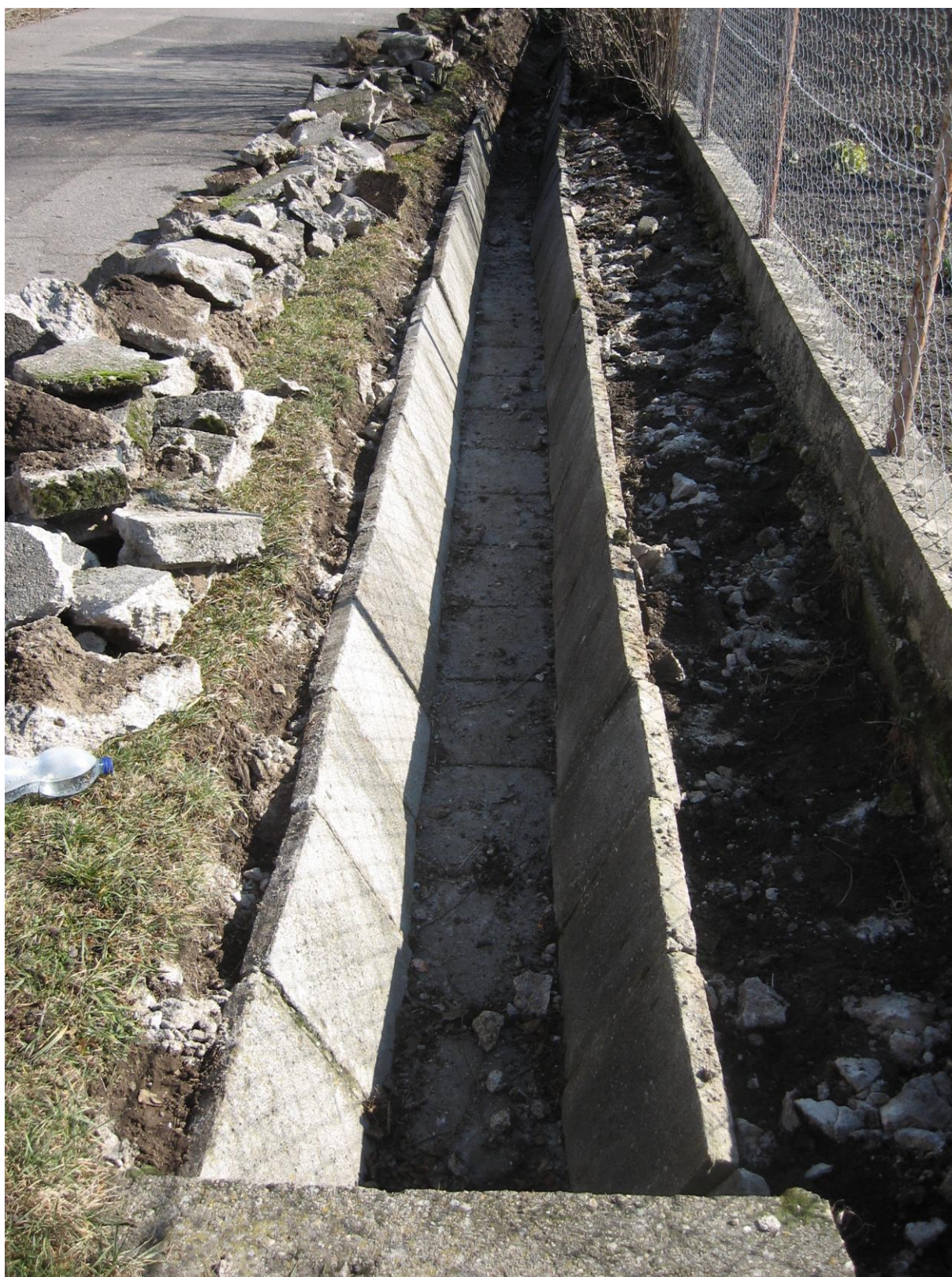
5.mélyépítési munkák előrehaladása
