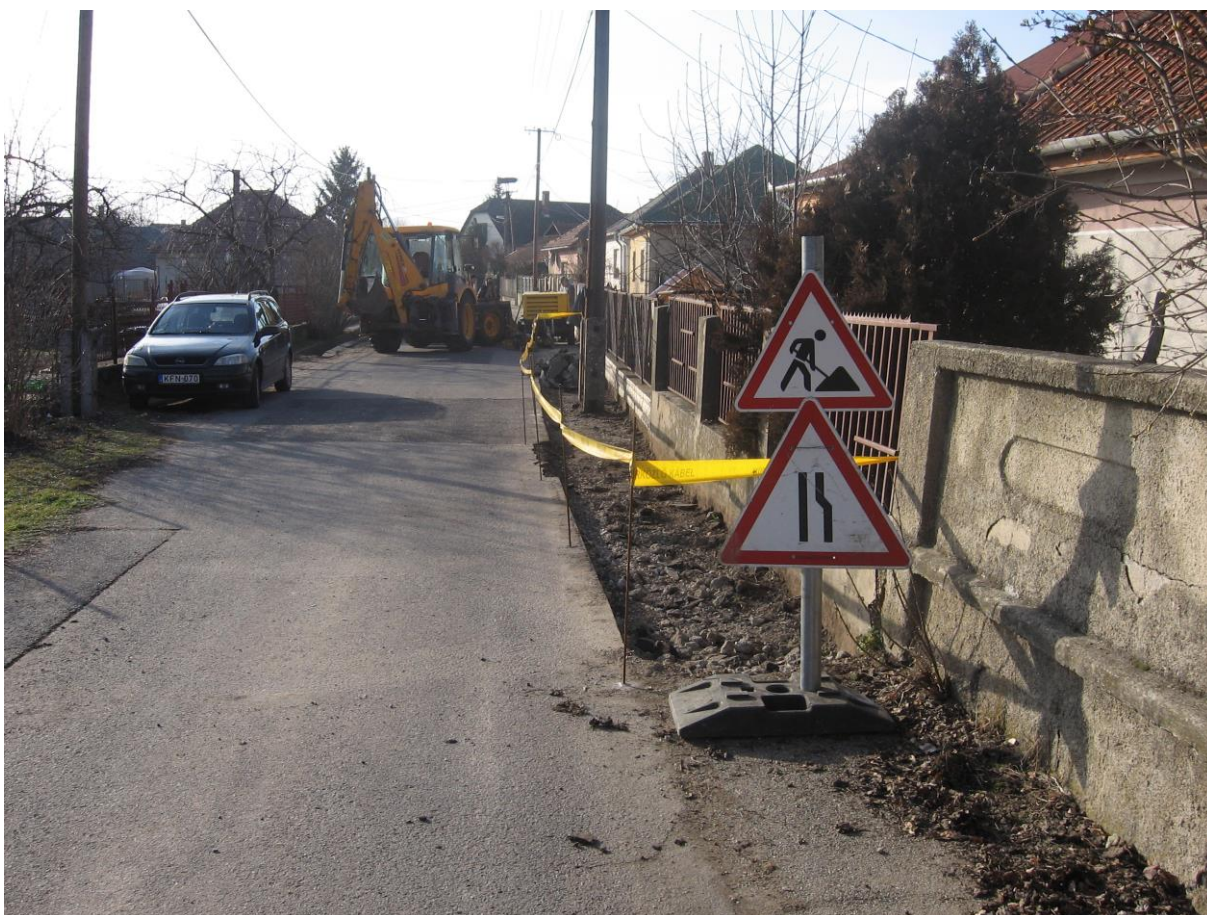
4. mélyépítési munkák előrehaladása
