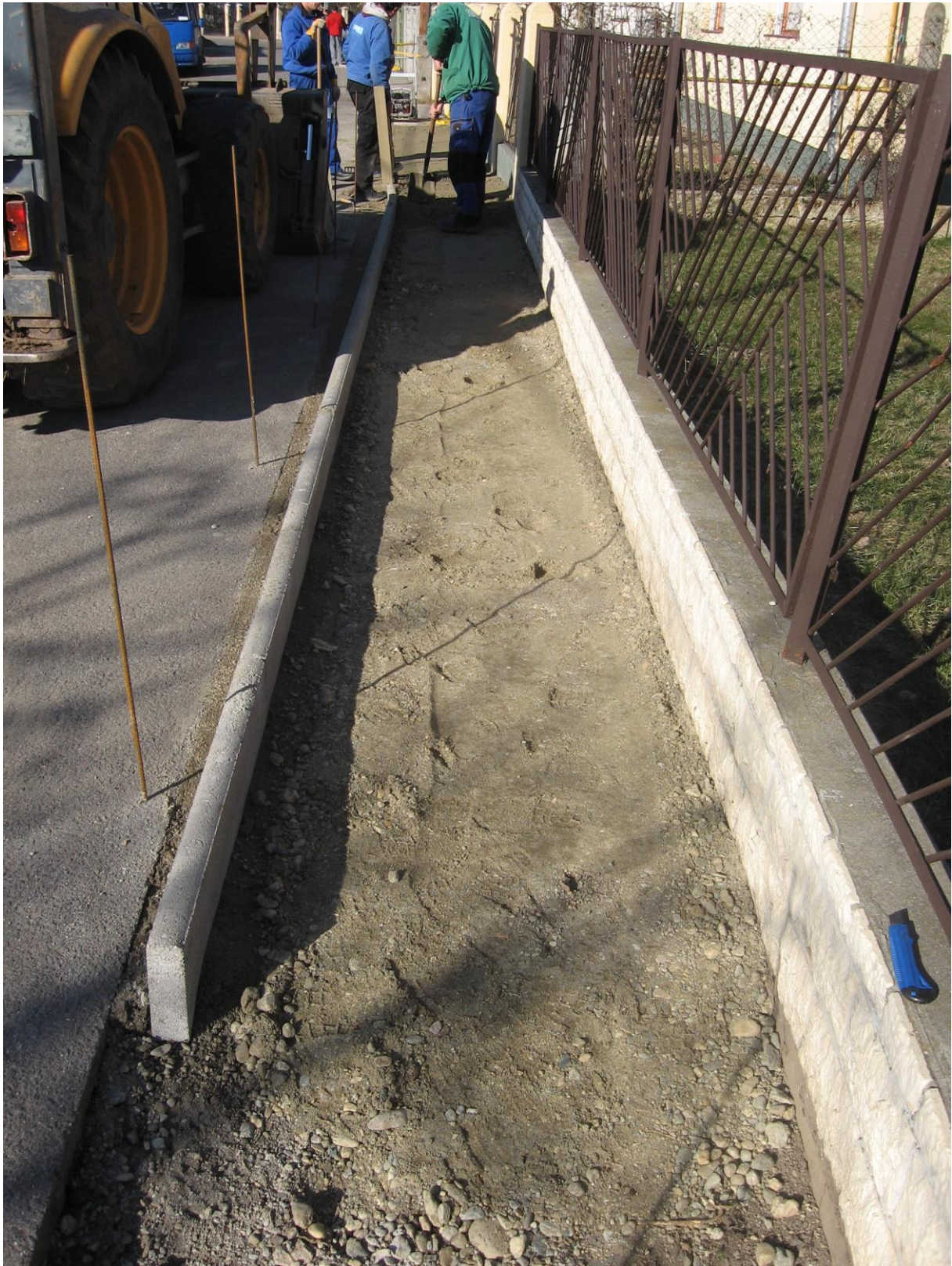
7. mélyépítési munkák előrehaladása
