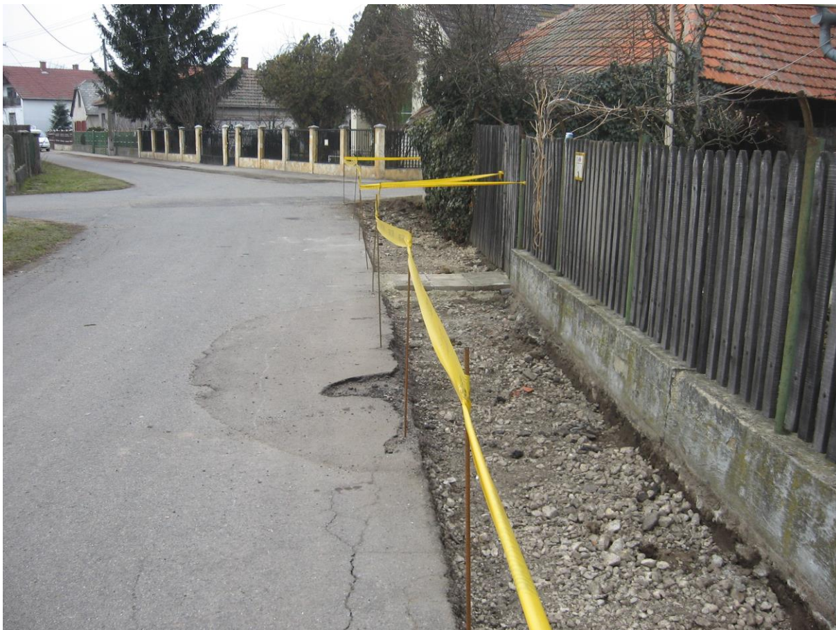
6. mélyépítési munkák előrehaladása
