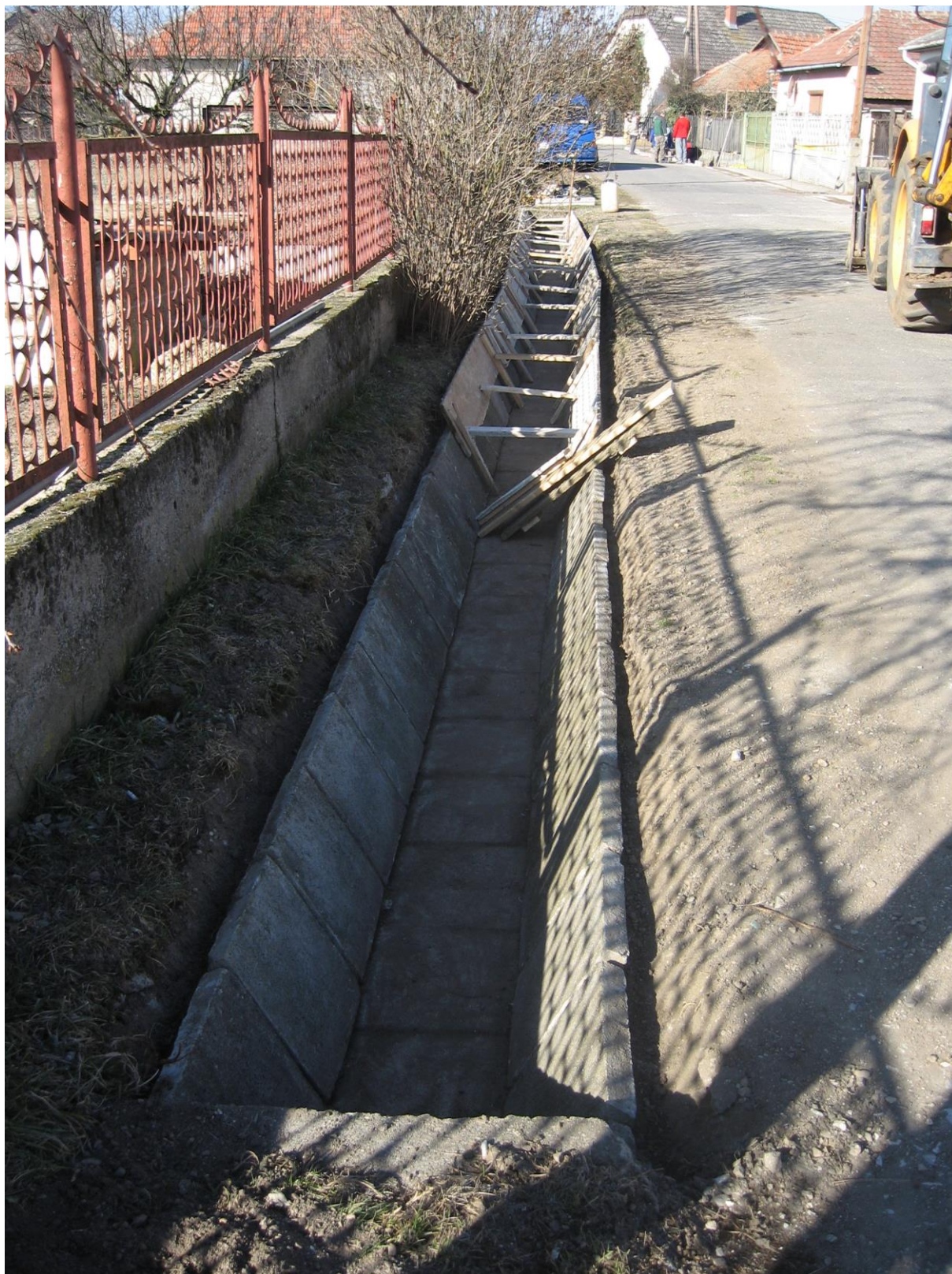
8. mélyépítési munkák előrehaladása
