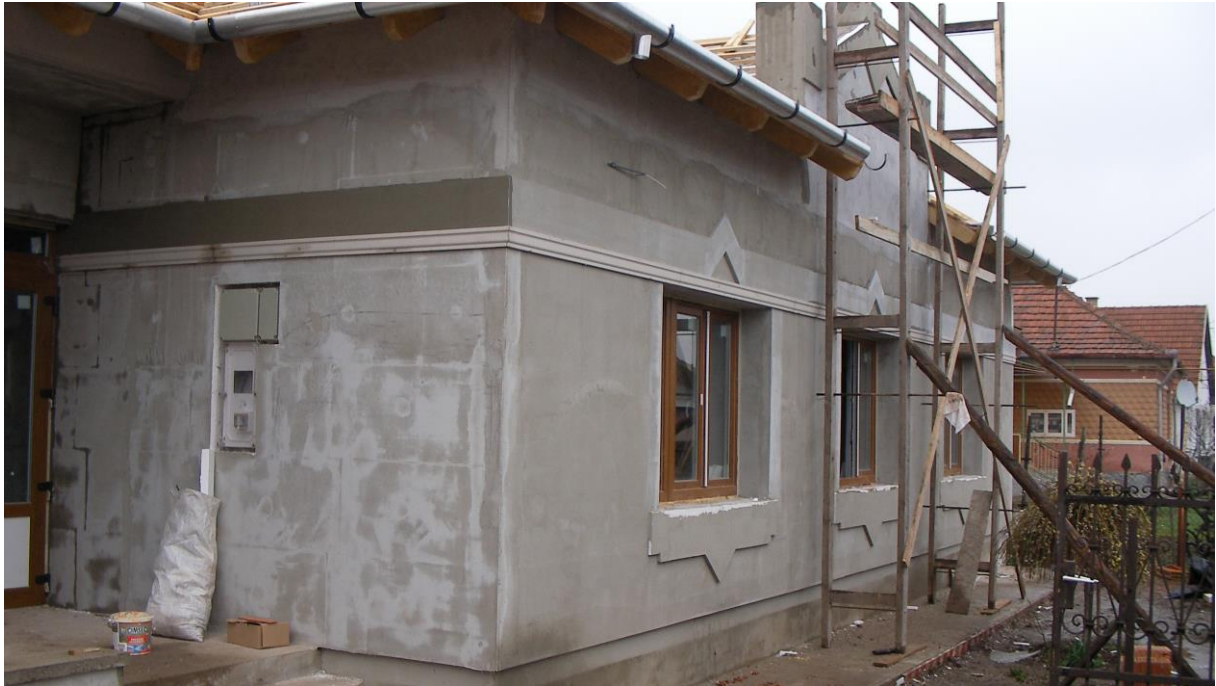
5. magasépítési munkák előrehaladása
