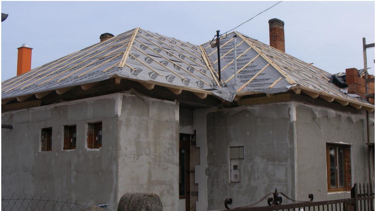
6. magasépítési munkák előrehaladása
