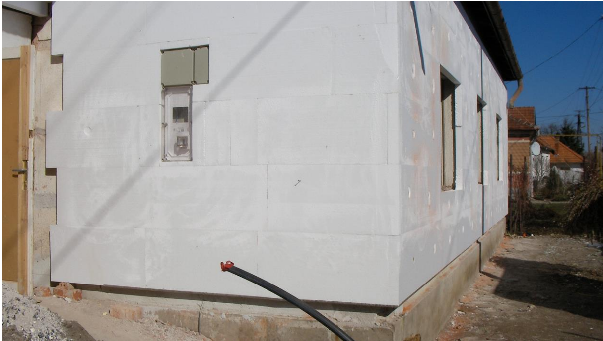
3. magasépítési munkák előrehaladása
