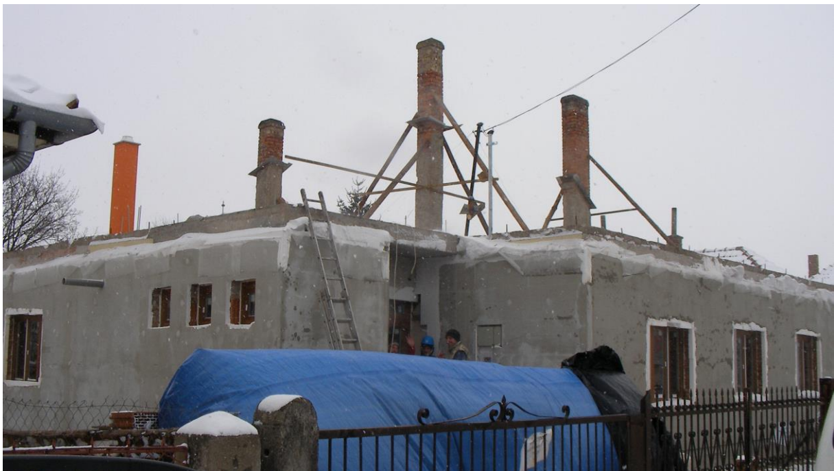
4. magasépítési munkák előrehaladása
