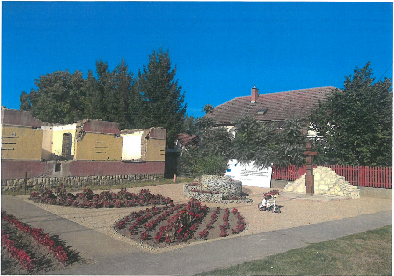
A tervezési területen lévő bontás alatt álló épület
