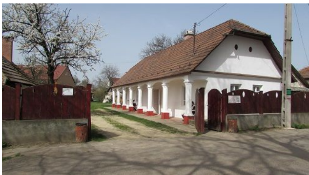
Bőcs, Hősök tere 9. 488 hrsz Tájház
